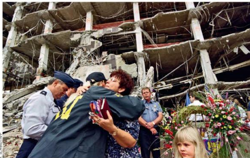
Le 19 avril 1995, à Oklahoma City, l'explosion d'un camion piégé devant le bâtiment fédéral Alfred P. Murrah tue 168 personnes.
