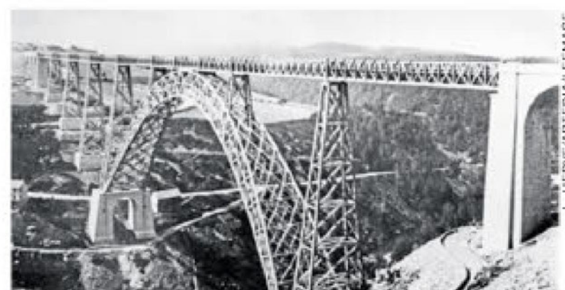
Achévé en 1884, le viaduc entre en service en 1888.
