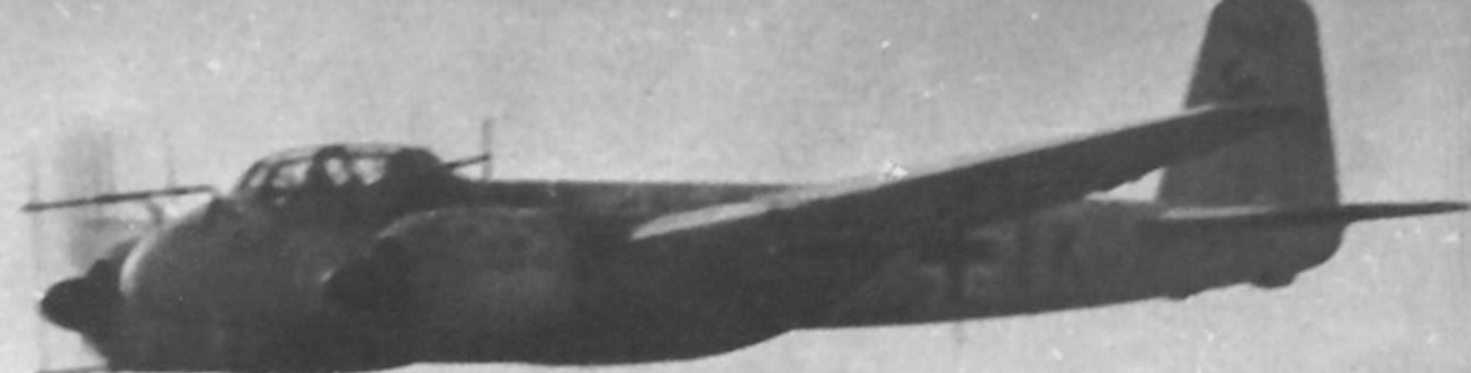
Un Ju 88 de la chasse de nuit lors d'un vol de transfert. Le radar de nez Liechtenstein est bien visible.
