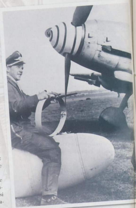
Un des pilotes allemands engagés dans la Reichsverteidigung. Il appartient probablement à la JG 3. On notera le réservoir auxiliaire sur lequel il est assis ainsi que la spirale blanche/noire peinte sur la casserole d'hélice. Ce dessin aurait été de nature à désorienter et à troubler les mitrailleurs adverses...
