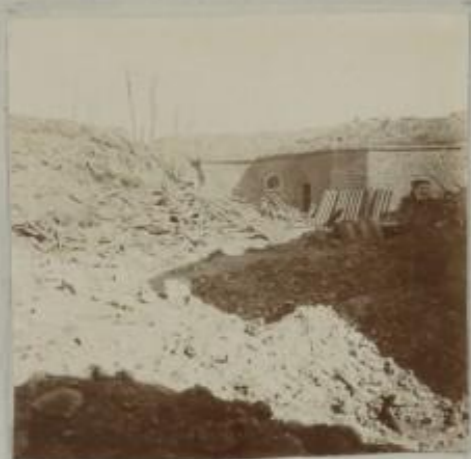
Souville Cour d'entrée - Dépôt du Matériel de Génie
