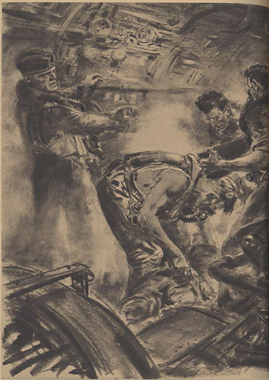
Die Abgasleitung der Dieselmachine ist gerissen. Im Maschinenraum nimmt der Dunst der Abgase zu. „Tauchretter anlegen!“ befiehlt der Leitende Ingenieur. Es ist
