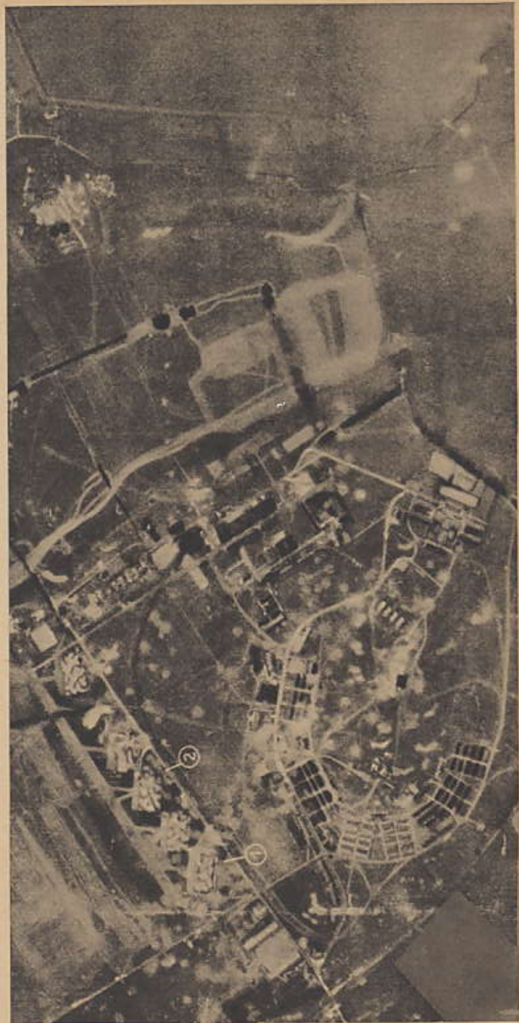
eine zweite (2) schwer beschädigt. Zahlreiche Bombentrichter liegen außerdem auf dem Rollfeld.
