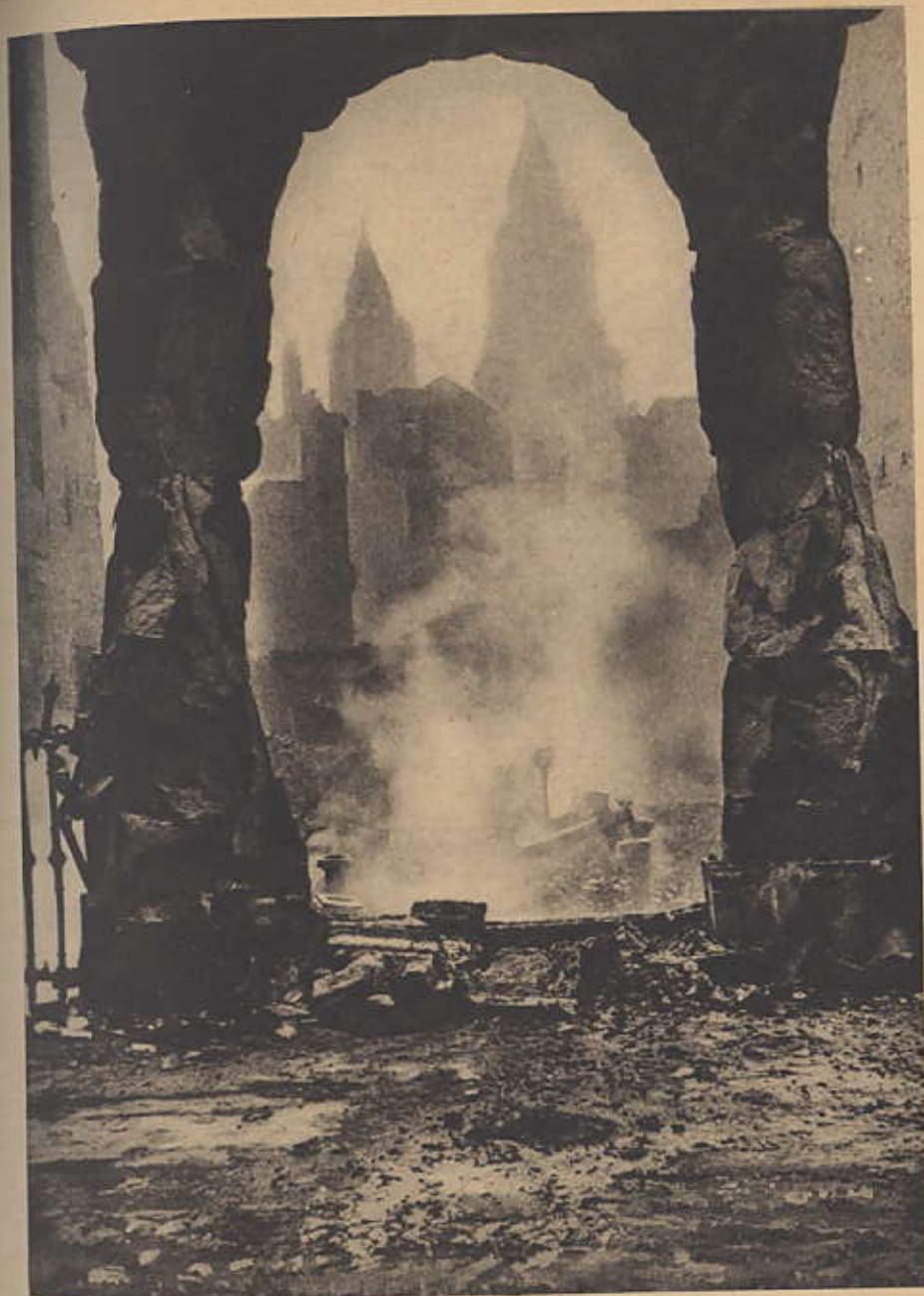
Präzisionsarbeit unserer Kampfflieger! Ein ganzer Stadtteil ist zerstört, aber unversehrt steht inmitten der Trümmer die Kirche. Die Aufnahme wurde einer amerikanischen Zeitschrift entnommen; sie strafe die britischen Behauptungen über „barbarische“ Angriffe deutscher Flieger Lügen.
