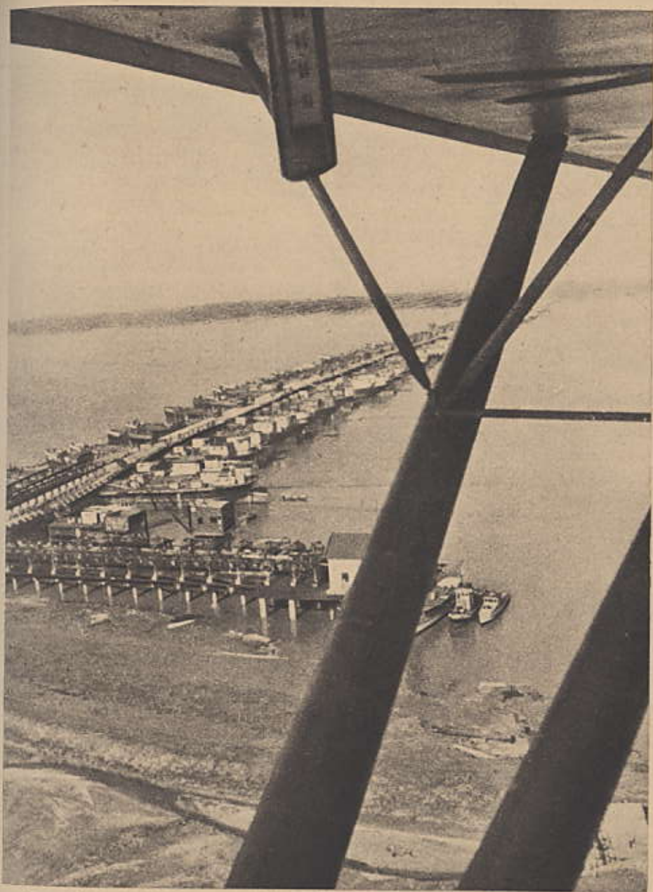
Die von deutschen Pionieren angelegte Donaubrücke, die das rumänische Ufer des Stroms mit dem bulgarischen verband. Da die Donau hier über einen Kilometer breit und 18 m tief ist, konnte infolge des häufig starken Wellengangs nur gedeckter Schiffsraum als Brückenträger verwandt werden. 60000 t umfaßte der für diese Brücke in Anspruch genommene Schiffsraum.
