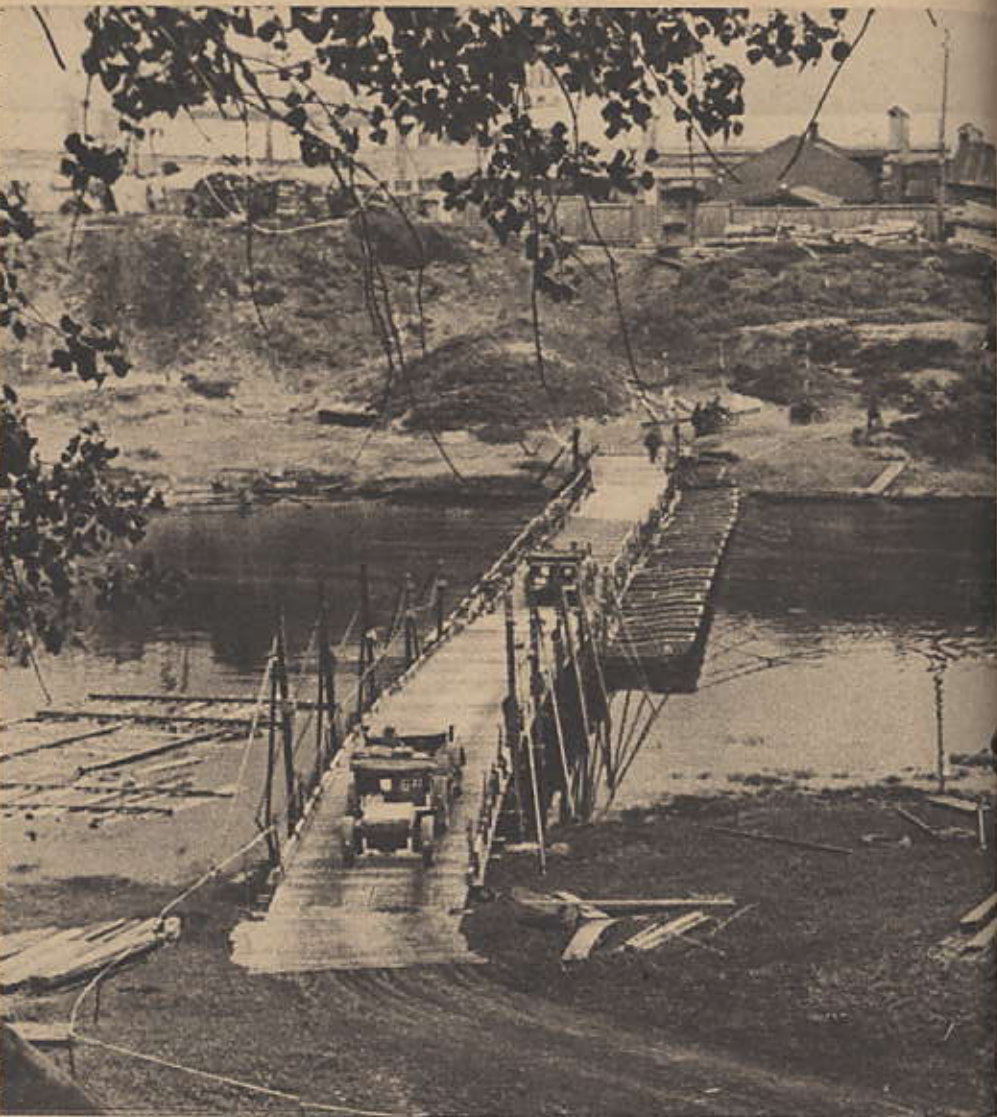
Im Nordteil von Smolensk, hinter dem Dnjepr, versuchte der Feind, sich noch einmal festzukrallen, bevor er die Stadt räumte. Die Brücken über den Fluß waren unpassierbar; Pioniere bauten infolgedessen, ständig dem feindlichen Feuer ausgesetzt, eine Kriegsbrücke, und bald war nach außerordentlich hartem Kampf auch der Nordteil der Stadt und damit ganz Smolensk in deutscher Hand.
