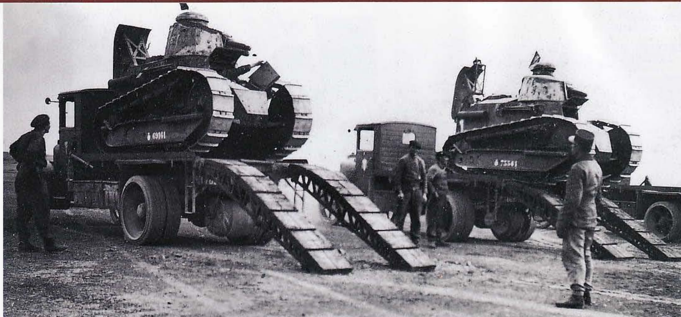
Manœuvre de montée ou de descente des chars Renault FT 69161 et 73541, tous deux des chars canon. L'insigne du bataillon est peint sur la portière des deux porte-char SAUREL 5 AD. (Coll. S. Bonnaud)
