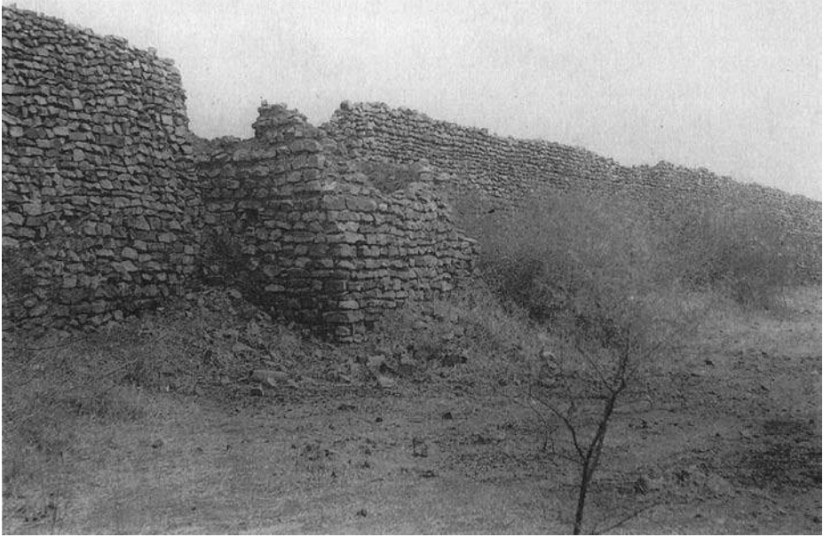
23.3. Ruines d'une tour de défense du tata [forteresse] d' Hamdallahi . [Photo : Institut fondamental d'Afrique noire (IFAN), Dakar.]
