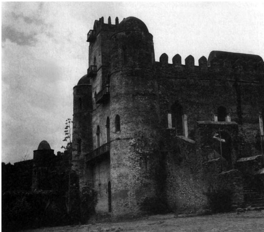
24.4. Le château de Gondar, la capitale éthiopienne construite par l'empereur Fasilidas. [© Werner Forman Archive, Londres.]
