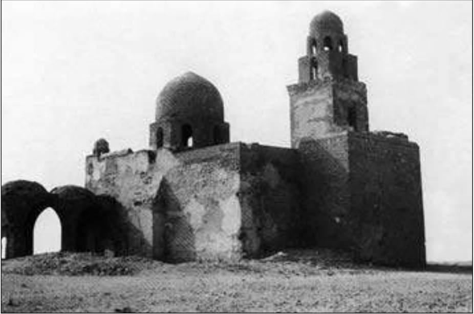
7.8. Mosquée al-Djuyūshī . Vue générale du côté est.
