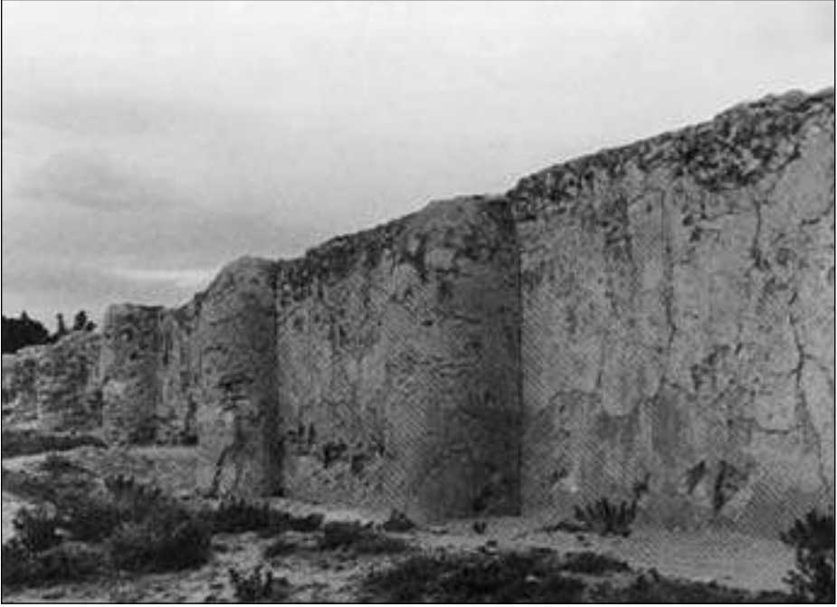
10.5. Le grand bassin de Raḳḳāda, près de Ḳayrawān ; les énormes contreforts brisaient les vagues provoquées par le vent.
