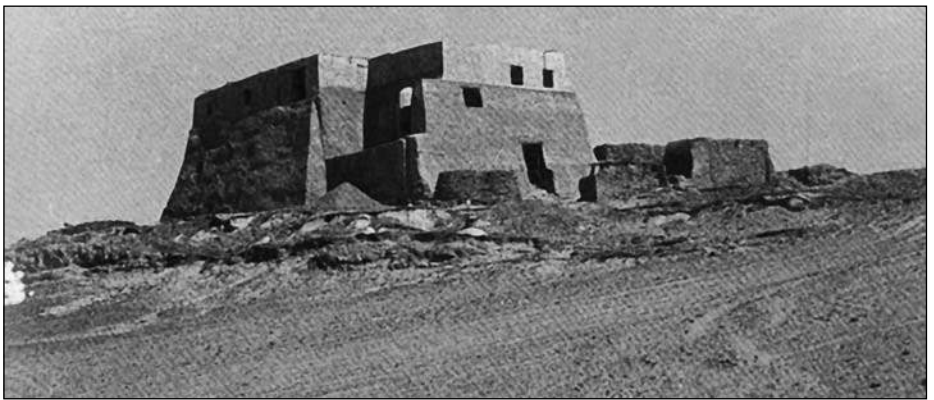
8.3. Le palais royal du vieux Dongola, transformé en mosquée en 1317.
