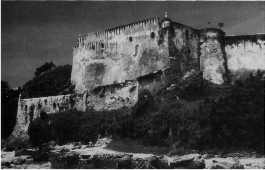
25.4. Fort Jésus (Mombasa) construit par les Portugais en 1593-1594. [Source: Cultural atlas , p. 57. © Spectrum Picture Library.]
