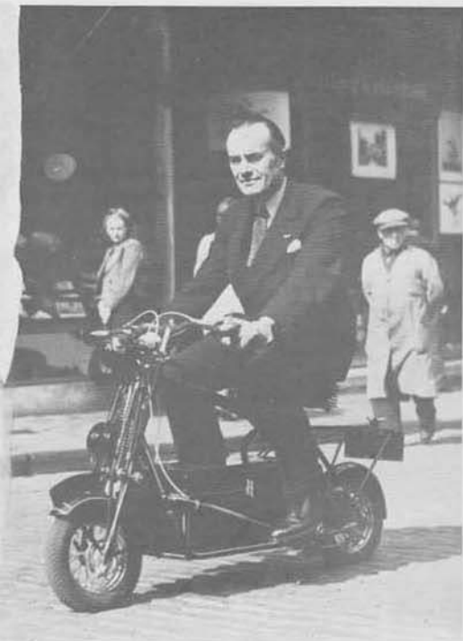
126. La moto électrique : 25 km à l'heure, des accumulateurs de 18 volts. Prix de vente : 6.200 F. Puissance du moteur ? Un demi cheval. Photo : Mus. R. de l'Armée
