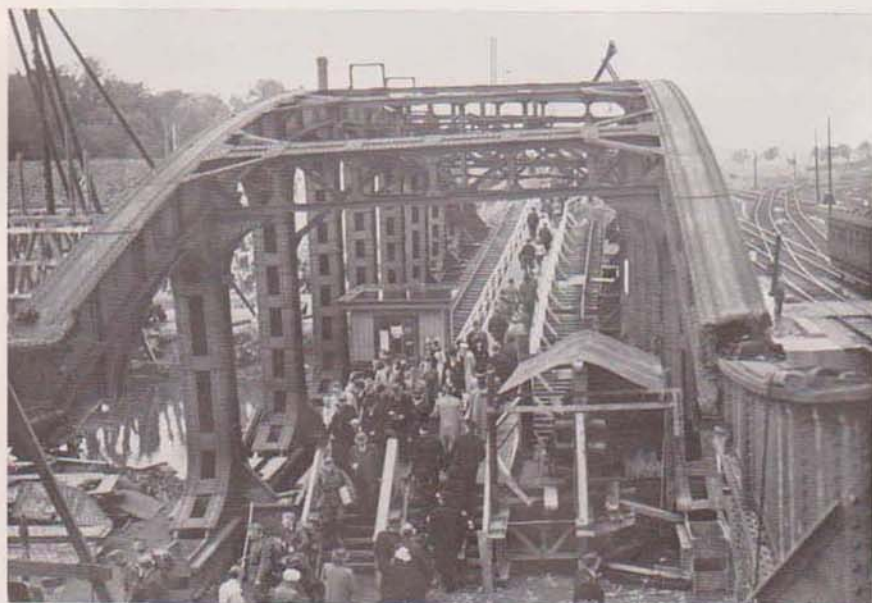
37. A cause de la destruction du pont sur la Dyle à Malines, le trafic ferroviaire entre Bruxelles et Anvers ne put reprendre qu'après la reconstruction de cet ouvrage d'art. Photo : Mus. R. de l'Armée
