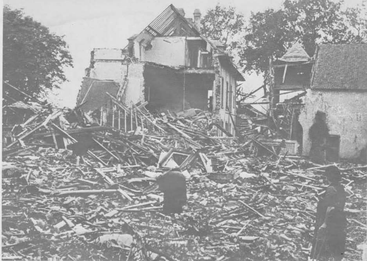
204. Avant de fuir, les Allemands ont dynamité cette maison qu'ils occupaient. Photo : Mus. R. de l'Armée
