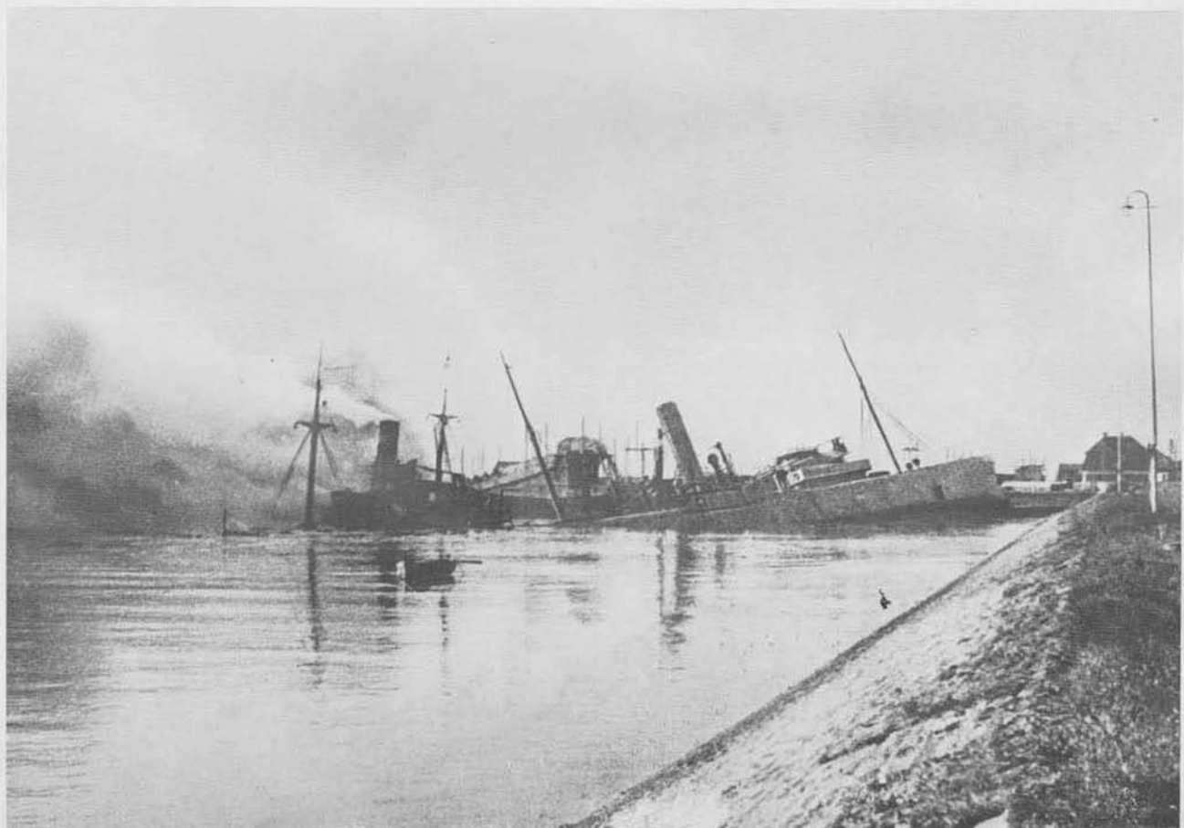
39. Deux bateaux remplis de béton pour empêcher l'accès au canal maritime à Zeebrugge. Photo : Mus. R. de l'Armée
