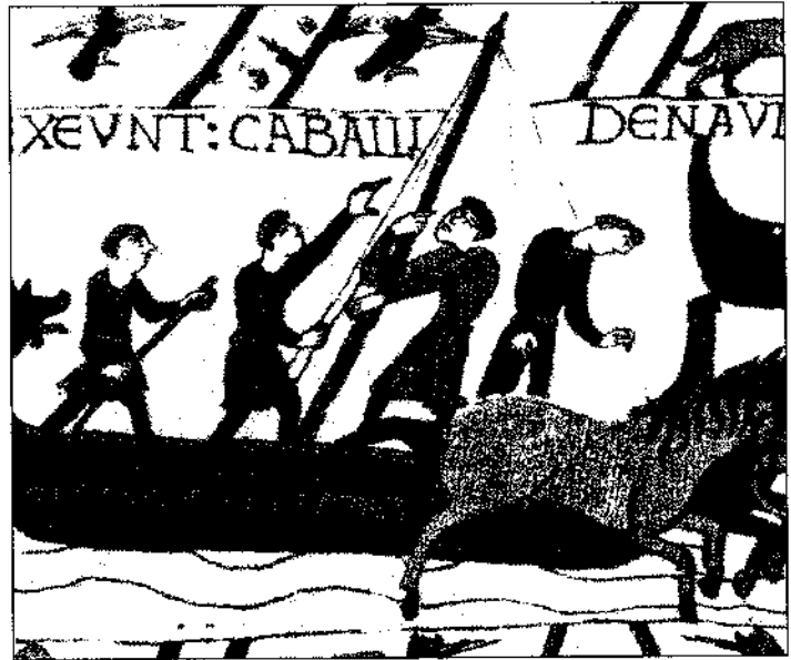
Une autre scène de la tapisserie de Bayeux représente des chevaux débarquant dans le baie de Pevensey.
